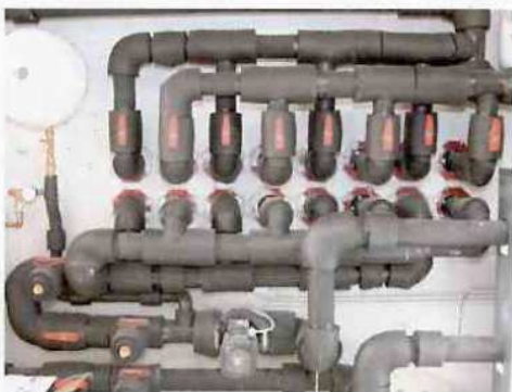
Hier wird die Erdwärme in die Wärmepumpe eingespeist.
