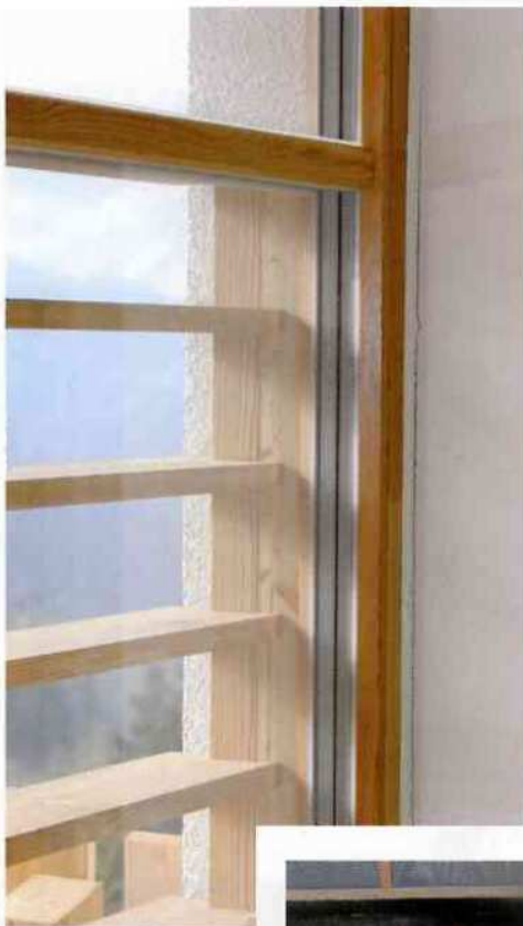
Kleines Detail, große Wirkung. Mauerwerk mit 20 cm Vollwärmeschutz-Isolierung und Fenstern mit Dreifach-Verglasung.
