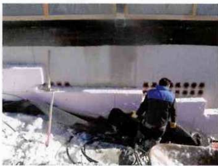
Hier wird die Erdwärme in die Wärmepumpe eingespeist.
